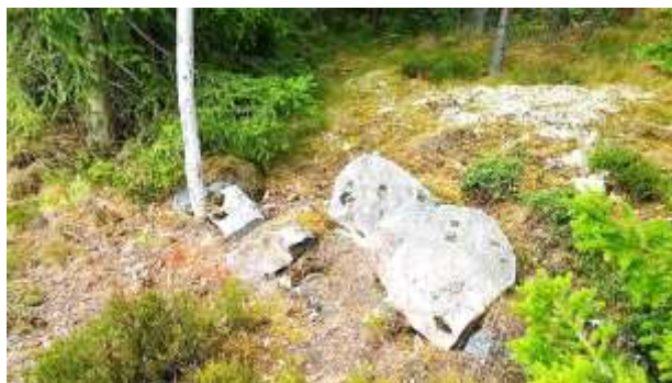
Vid Stora Älgerum ; raserat milstolpsfundament
