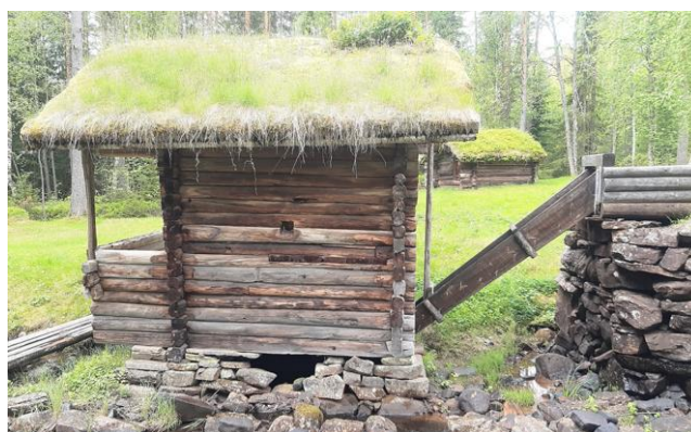
Exempel på skvaltkvarn. Kvarnhuset stod bredvid bäcken. Vid malning leddes vattnet ifrån bäcken via trärännan till höger, in under kvarnen till kvarnhjulet till vänster. Foto Lars Carlsson 2022.
